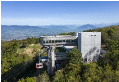
Façade ouest. Le haut mur d'escalade comme la tour-escalier qu'il dissimule sont réalisés en béton préfabriqué.
