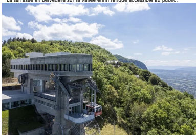
Proue de la gare haute dont l'implantation des piliers correspond au franchissement d'une zone calcaire instable.
