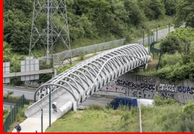
Ce simple ouvrage d'art bénéficie à des milliers d'employés de la ZAC dont le temps de déplacement depuis la station de RER se trouve réduit.
