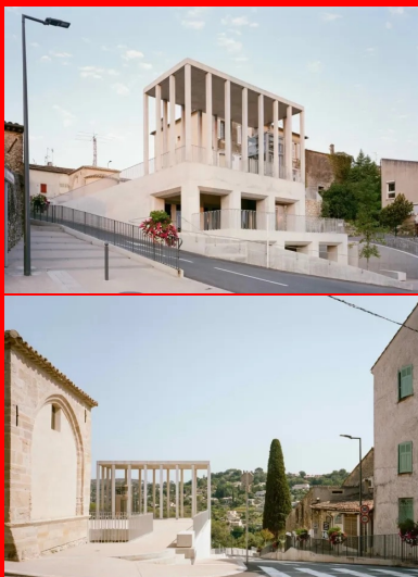
Avec ses poteaux élancés, le pavillon joue d'un côté le rôle de signal urbain et, de l'autre, de cadrage sur le paysage.
