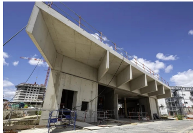
Gare de Bagneux-Lucie-Aubrac, Atelier Barani, architectes, photo : © Gérard Rollando
