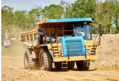
Les matériaux repris sur le stock sont acheminés à l'aide de tombereaux articulés pour être utilisés dans la confection des remblais et de la couche de forme. © Guintoli - NGE
