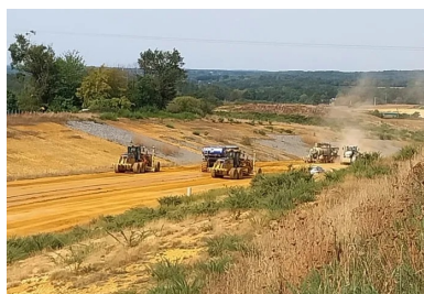
Vue générale du chantier de terrassement, conçu en circuit fermé déblais-remblais. (© Guintoli - NGE)
