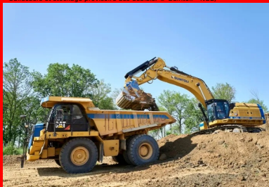
Reprise des déblais sur stock à l'aide d'une pelle sur chenilles et de tombereaux articulés. © Guintoli - NGE
