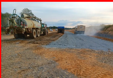
Epanchage du LHR Rolac Premier ECOPlanet à la surface du matériau à l'aide d'un épancheur asservi avec contrôle pondéral. © Guintoli - NGE
