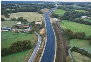
Vue générale après travaux. (© Guintoli/groupe NGE)
