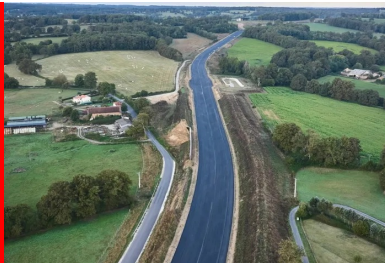
Vue générale après travaux. (© Guintoli/groupe NGE)
