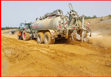
L'arrasseuse à enfouissement garantit une teneur en eau optimale.
