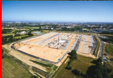
Deux vues aériennes du chantier, l'une en avril 2017 (où le traitement de plate-forme s'achève), l'autre deux mois plus tard, en juin 2017 (où la construction des premiers bâtiments commence).
