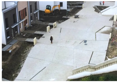
L'une des voies de circulation douce, réalisées en béton désactivé, devant les logements pavillonnaires du nouveau quartier.
