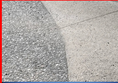
Autre exemple de la diversité des finitions (microbouchardage et désactivation), avec la maîtrise du sciage et de l'intégration des joints au projet esthétique.
