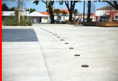
Des inserts pour le repérage du cheminement et l'éclairage de perspective. En médaillon, le béton noir lissé, réalisé côté est, pour créer un contraste.
