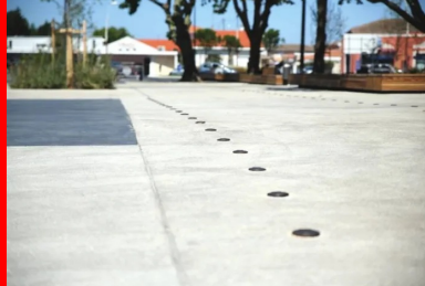
Des inserts pour le repérage du cheminement et l'é et de perspective. En médaillon, le béton noir lissé, réalisé côté est, pour créer un contraste.
