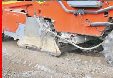
Le rotor du malaxeur mélange le matériau fragmenté de l'ancienne chaussée avec le liant Equiom ROC AS dosé à 4 %.
