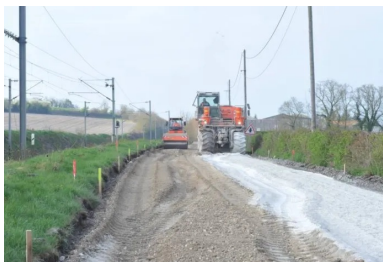
Le malaxeur entre en action après l'épandage du liant hydraulique.
