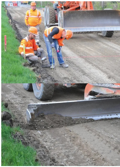
Prise de mesure de la hauteur de la chaussée retraitée avant réglage.
