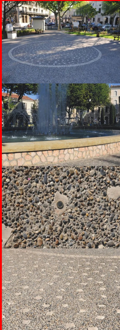
Le béton désactivé avec granulats roulés de Durance, cloutés de petits pavés calcaires, a métamorphosé le square Charles-de-Gaule.
