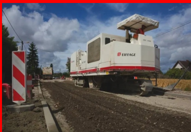
En milieu urbain, la présence de bordures, de tampons de voirie ou de bouches à clé n'empêche pas la mise en œuvre du retraitement en place. Solution choisie par Eiffage-Route sur ce chantier : les abaisser, avant de les relever.
