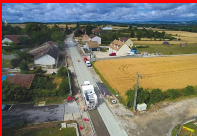
Fin juin 2017, à Demigny (Saône-et-Loire). Après épandage du liant hydraulique routier Vicat (LV-TS03) par l'Arc Dosage (en haut de la photo), l'Arc 1000 (au premier plan) décohésionne les matériaux de l'ancienne chaussée et procède à un puissant malaxage pour obtenir un mélange homogène.
