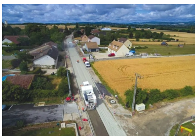
Fin juin 2017, à Demigny (Saône-et-Loire). Après épandage du liant hydraulique routier Vicat (LV-TS03) par l'Arc Dosage (en haut de la photo), l'Arc 1000 (au premier plan) décohesionne les matériaux de l'ancienne chaussée et procède à un puissant malaxage pour obtenir un mélange homogène.
