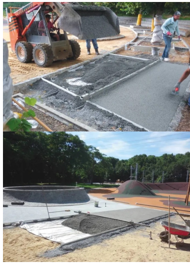
Le béton a été acheminé à l'aide d'une chargeuse et mis en œuvre manuellement par l'équipe de Val-de-Loire Environnement.
