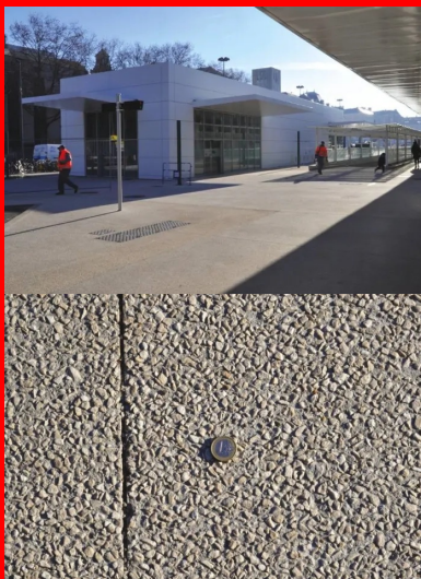
La gare routière est située dans le prolongement du terminal ferroviaire.
