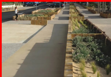
Les trottoirs en béton de sable, agrémentés de jardinières.
