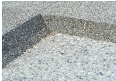
Des bordures inclinées pour une transition douce entre trottoirs et voirie.
