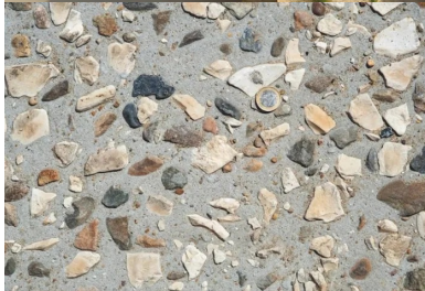
Le béton « cyclopéen » (voirie et parking).
