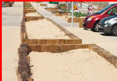
Un béton faiblement désactivé a été mis en œuvre, notamment sur la place des Basques.
