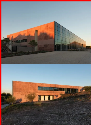
Les pignons ont été travaillés pour donner une impression de masse. Le béton reprend les teintes rouges de la colline.
