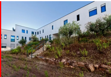
À l'intérieur, un vaste patio central permet de faire entrer la lumière naturelle dans les locaux.
