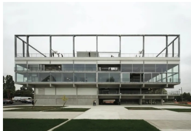
Pas de hiérarchisation des façades qui sont traitées selon le même principe.
