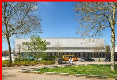
Le rythme vertical des baies du RDC répond à l'horizontalité des lames de béton des étages.
