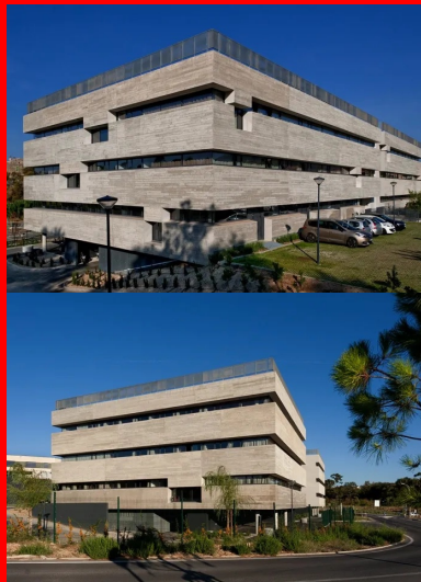
Angle est. Les panneaux des façades périphériques en béton brut de décoffrage contribuent au caractère moderne de l'édifice. Le fonctionnement intérieur est invisible depuis l'extérieur.
