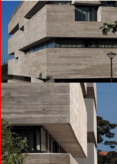
Les décalages d'éléments en béton animent le traitement horizontal des façades.
