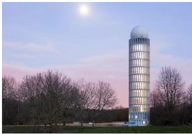
Haut de 57 m, le fût cylindrique de la tour radar se compose de 308 claires-voies ouvrant en partie basse sur le paysage et en partie haute sur le ciel et ses variations.
