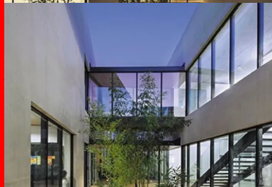
le patio qui sépare les deux parties du bâtiment est à la fois un puits de lumière et un espace de liaison.
