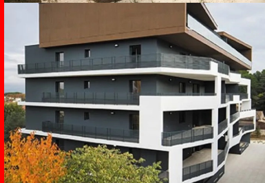
Bâtiment haut, angle nord-ouest, les loggias de la façade principale se prolongent en balcon vers le nord.
