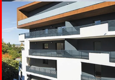
Façade principale du bâtiment haut avec ses grandes loggias orientées sud-ouest dont les rives en béton peint en blanc soulignent le dépiement.
