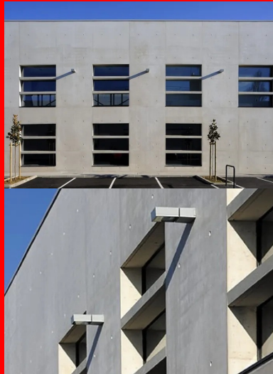
Façade sud, des brise-soleil en béton préfabriqués protègent les ouvertures du rayonnement tout en participant à leur redécoupage.
