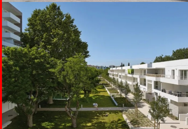
En limite est, le bâti en r+2 est plus domestique et volontairement poreux pour préserver les vues vers le panorama sur la chaîne saint-cyr.
