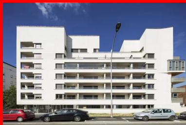
La scansion des loggias et les découpes du béton rythment la façade.
