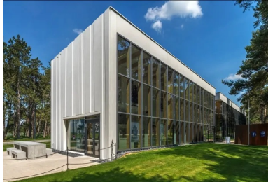
Façade ouest, le volume de béton se creuse face à la forêt.
