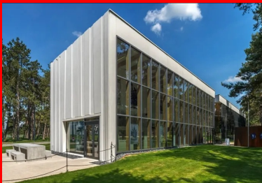
Façade ouest, le volume de béton se creuse face à la forêt.
