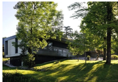
La maison tourne volontairement le dos aux constructions avoisinantes, côté nord, a n d'orienter tous les espaces vers le sud et les vues dégagées sur le paysage. La toiture-terrasse est entièrement végétalisée de façon intensive.
