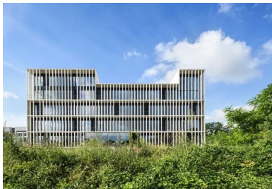
Une pergola accessible double la façade nord.
