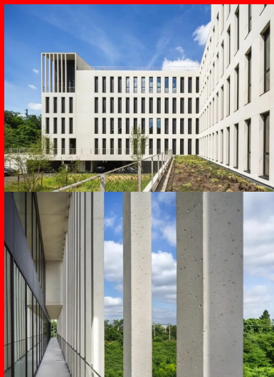
Une pergola accessible double la façade nord.
