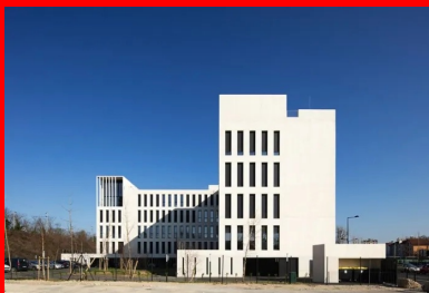
La construction sur pilotis permet l'écoulement des eaux en cas de crue.
