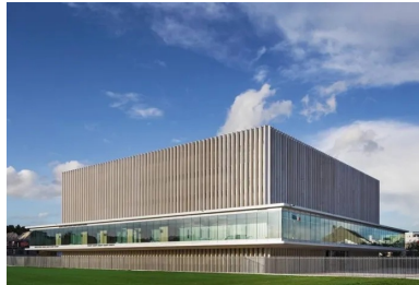
Angle sud-ouest. expression d'une justice égalitaire, les quatre façades sont quasi identiques. la colonnade en béton clair joue comme des ventelles plus ou moins ouvertes suivant le point de vue adopté.
