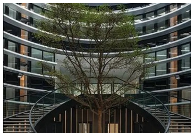
L'atrium amène la lumière au cœur du bâtiment et, par ses ouvertures en partie haute, participe à sa ventilation naturelle.
