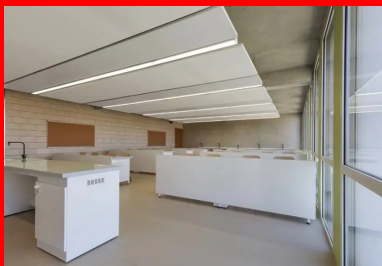
Séparatifs et porteurs en béton participent au confort thermique d'été.
