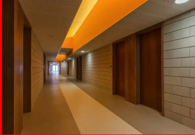
Les cloisonnements intérieurs sont réalisés en blocs de béton à bancher.
