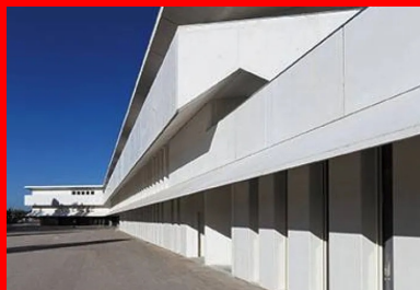
Déboîts de dalles et toitures sont dessinés pour faire une large place à l'éclairage naturel.
