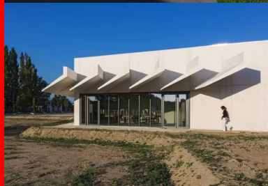
Le collège est perçu par le pignon le long de l'axe de circulation principal, les architectes lui ont donné une dimension sculpturale.
