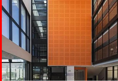
L'Atrium assure la connexion entre les bâtiments d'enseignement.
