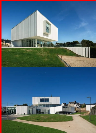
Jeu de contraste entre la masse assez fermée du musée à l'étage et l'espace vitré de l'accueil.
