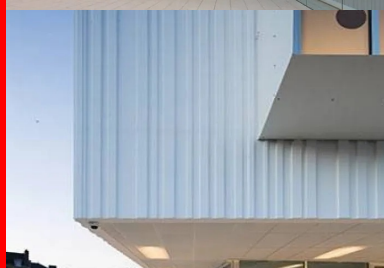
Des cannelures verticales ont été réalisées à partir de matrices soigneusement dessinées par les architectes.
