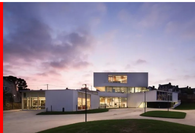
Les masses de béton sont en lévitation grâce aux jeux de transparence.
