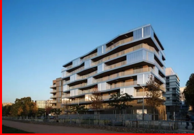
La façade ouest longe la promenade de l'aqueduc.
