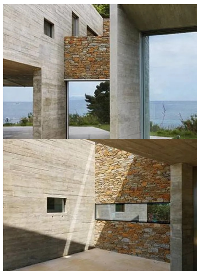
Les parois extérieures, les plafonds et les refends intérieurs sont réalisés en béton brut dans des coffrages en pin.
