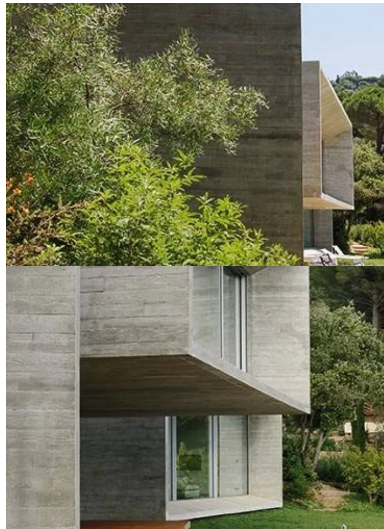
Les parois extérieures, les plafonds et les refends intérieurs sont réalisés en béton brut dans des coffrages en pin.
