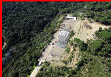
La toiture en partie végétalisée avec des espèces locales, complète l'intégration.
