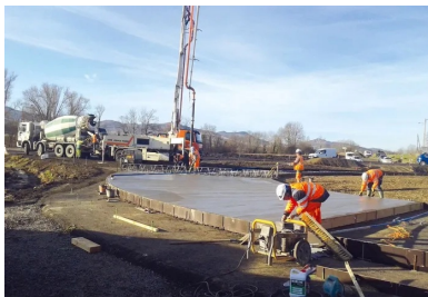
Le coulage de l'anneau en béton a été réalisé en une seule journée, avec l'utilisation d'une pompe à béton automotrice.
