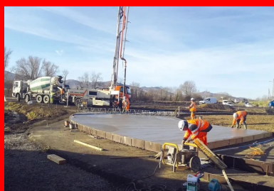
Le coulage de l'anneau en béton a été réalisé en une seule journée, avec l'utilisation d'une pompe à béton automatisée.
