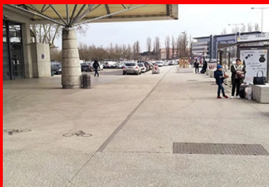
L'entrée du marché couvert, côté nord de la rue du 4-Septembre. De vastes trottoirs en béton bouchardé de couleur beige clair donnent accès au nouveau pôle d'échanges « bus ».
