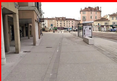
La rue du 4-Septembre (ici côté sud) a vu la superficie de ses trottoirs - en béton bouchardé - tripler en superficie. En médaillon : le béton - un C25/30 classé XF2 à base de ciment Vicat CEM I 52,5 - intégrant du Comblanchien, de calibre 20/40 et 16/22.
