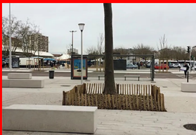
La présence de nombreuses fosses d'arbres et la fréquentation des lieux ont rendu le coulage du béton délicat. Au premier plan, des joints de sciage, dont la présence a été limitée au profit de bandes structurantes en pavé.
