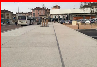
Bus, pistes cyclables et béton décoratif sont mis en service pour favoriser les « modes de déplacement doux »
