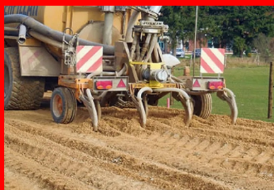
Après fragmentation de l'ancienne chaussée, une humidification se révèle nécessaire.
