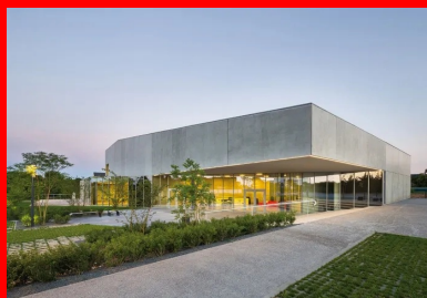
Par les découpes des vides et des pleins, l'architecture fait écho aux fonctions de l'équipement, mais aussi à sa capacité d'insertion urbaine.
