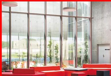
Le hall et la paroi de béton qui délimite le volume de la salle.
