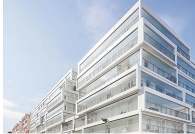
Seule exception au jeu de décalage, les loggias situées en pignon et faisant face au bâtiment mitoyen.
