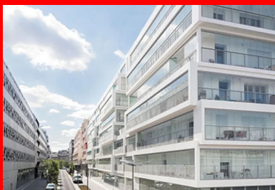
Un empilement de boîtes en béton qui doit sa légèreté aux façades entièrement vitrées.
