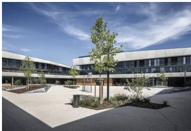
Cour centrale : les bandeaux de béton brut cernent des parois en métal et verre.
