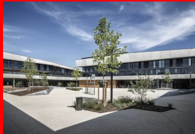
Cour centrale : les bandeaux de béton brut ciment des parois en métal et verre.
