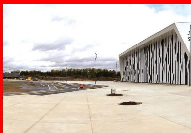
70 % des 10 000 m 2 de surface réalisée ont bénéficié d'un revêtement en béton sablé.
