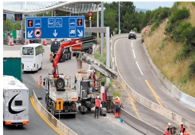
Particularité du chantier : travailler sur une infrastructure ouverte à la circulation
