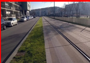
La plate-forme du tramway T6 est constituée d'une dalle courte en béton non armé et goujonné.
