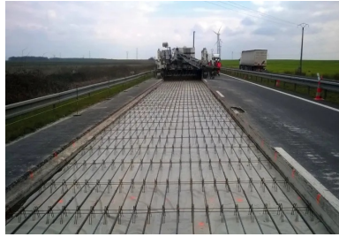
Deux phases de l'intervention sur l'A71 : mise en place des barres en acier haute adhérence HA 16 le mardi et bétonnage à la machine à coffrages glissants le mercredi.
