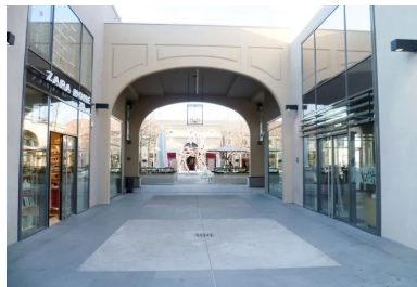
Au total, le béton micro-désactivé a été mis en œuvre sur une superficie de 1 702 m 2 .
