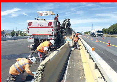
La glissière en béton est extrudée à la machine.
