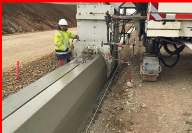
Mise en œuvre d'un caniveau à fente.
