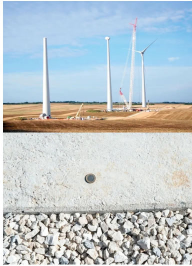
Des éoliennes E82/2300 en cours d'assemblage.
