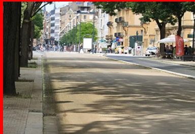
La couche de roulement a adopté di érentes colorations selon le tissu urbain : couleur grise naturelle dans les nouveaux quartiers, basalte pour les carrefours et ocre-jaune teinté dans la masse en centre-ville.
