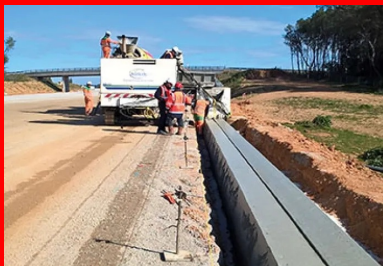
Au total, Agilis réalisera 90 km de séparateurs simples en béton adhérent (GBA) (photo du haut) et 12 km de caniveaux à fente (photo du bas).
