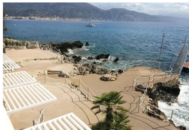
Vue des « terrasses de plage ». Le choix du revêtement en béton décoratif a été guidé par des « considérations essentiellement esthétiques », souligne Éric Luong, responsable de projet au sein du cabinet Wilmotte.
