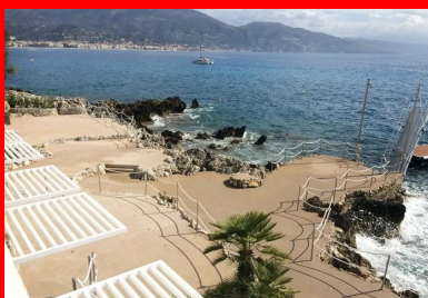
Vue des « terrasses de plage ». Le choix du revêtement en béton décoratif a été guidé par des « considérations essentiellement esthétiques », souligne Eric Luong, responsable de projet au sein du cabinet Wilmotte.
